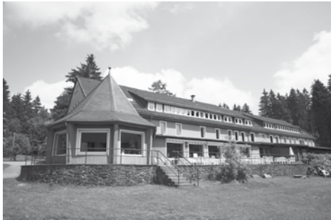
Foto: Flambacher Mühle
