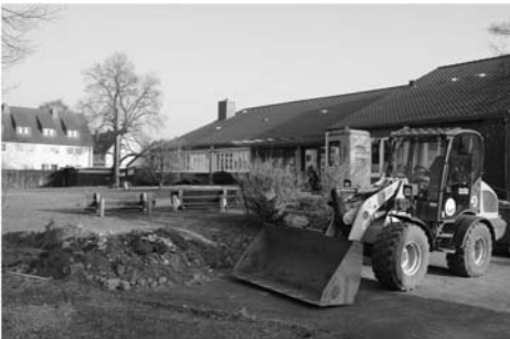
Auf der Westseite (Rehkamp) des Geländes sieht es Anfang März noch richtig „nach Baustelle“ aus...
